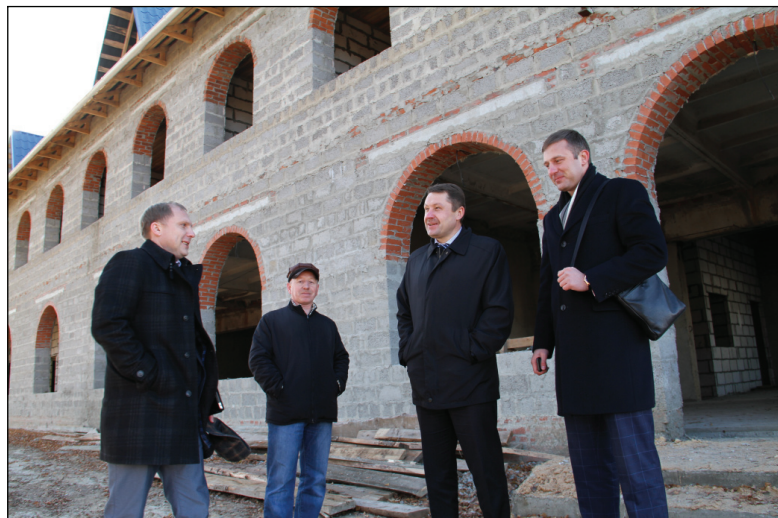
• Члены делегации на строящемся объекте ИП Платонова А.А.
